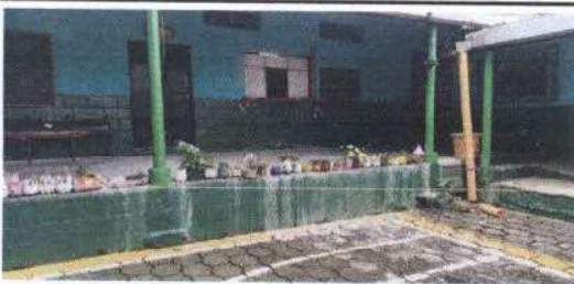
Foto 5.: Ventanas y puertas
