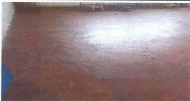
Foto 5: cambio de piso para solon multusos.
