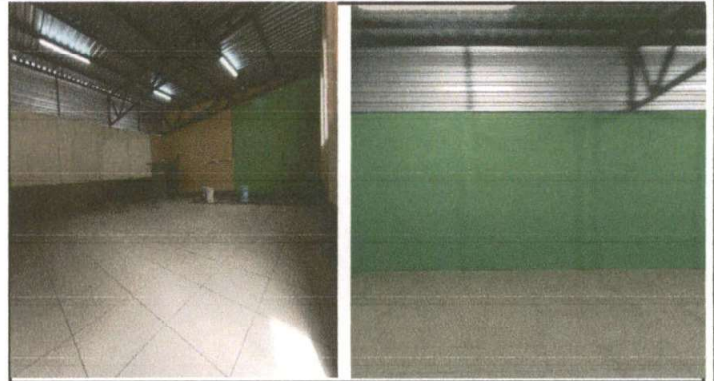
Foto 2: Piso Cerámico instalado en el área de cocina
