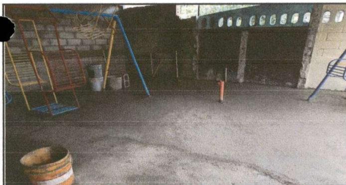
Foto 5: Fundición de contra piso en el área de juegos
