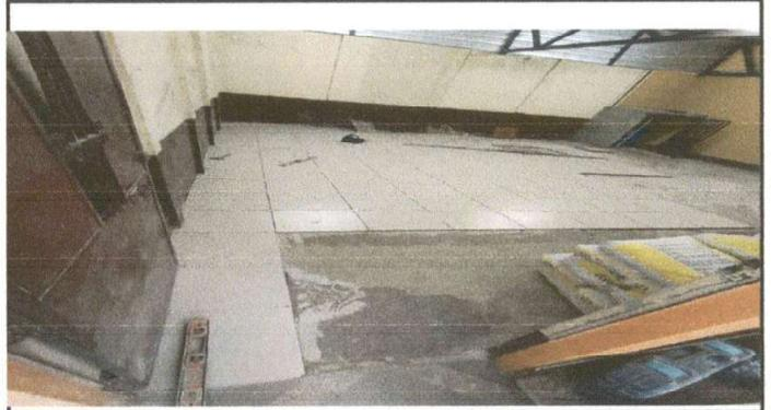
Foto 2: Instalación de piso cerámico en la cocina
