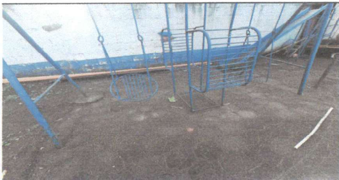
Foto: 5 Colocación de contra piso base de concreto
