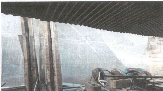
Foto: 3 El complemento del muro perimetral vecino.
