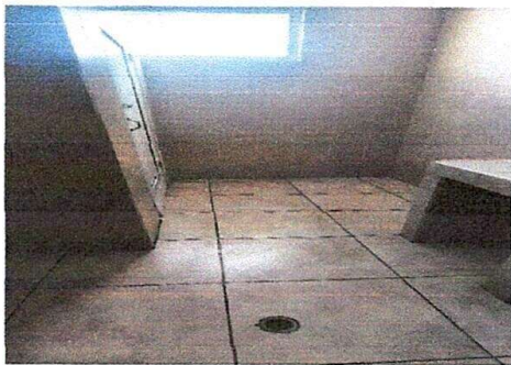
Foto 3: Necesita corrección de reposadera a nueva conexión
