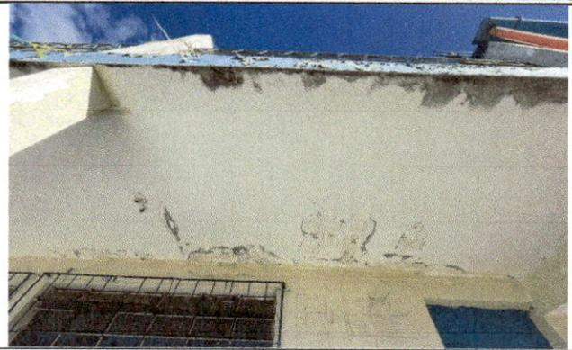
Foto 2: Módulo A, losa interior en mal estado
