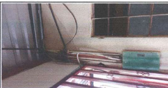
Foto11.: CAMBIO DE INSTALACION ELECTRICA
