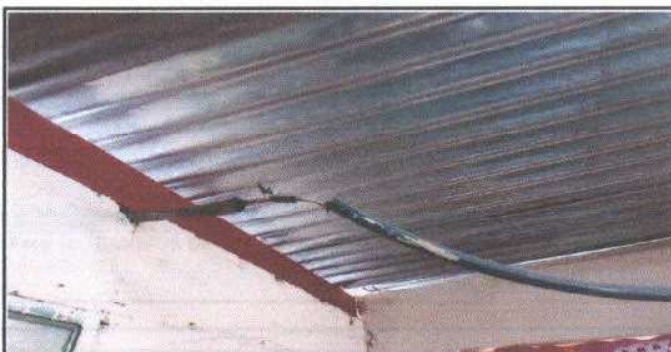
Foto 12.: CABLES EXPUESTOS
