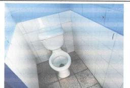
Foto 3: Modulo 1, Sanitario en mal estado es necesario sustituirlo
