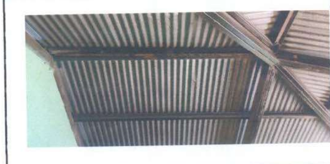
Foto 4.: Cambio de láminas
