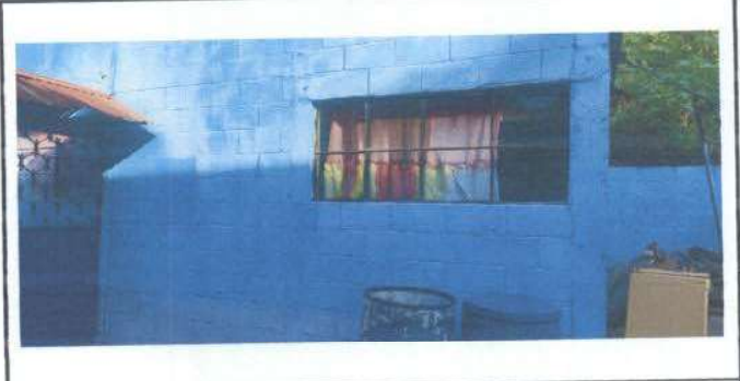
Foto 2.: Ampliación de ventana
