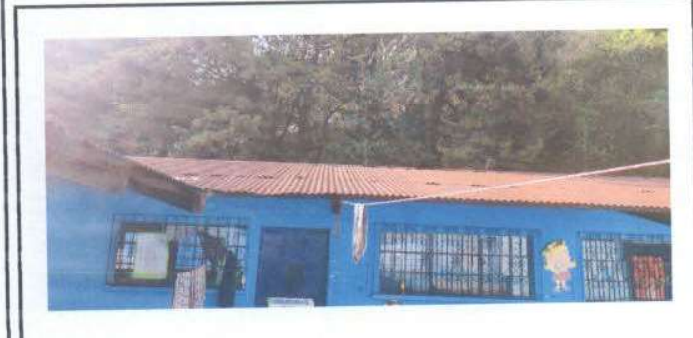
Foto 3.: Techado de aulas
