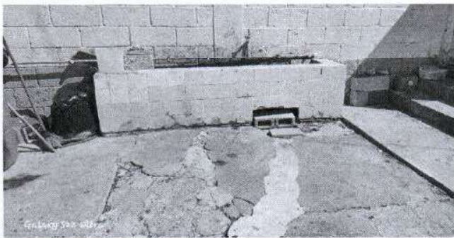
Foto 5: Área para instalación de otro servicio sanitario
