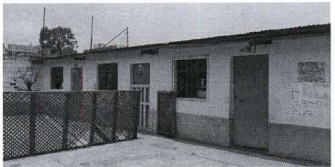
Foto 4: Área para pintura
