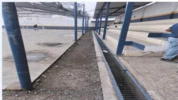
Foto 3.: canal y bajadas pluviales
