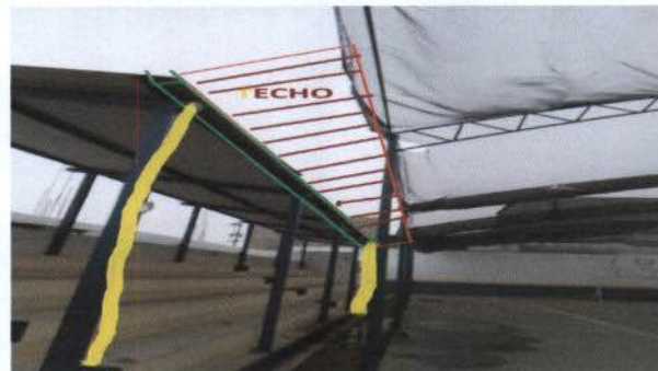
Foto 4.: Ampliación de cubierta y bajadas pluviales
