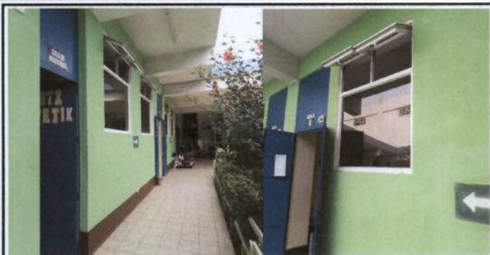
Foto 1.: Área de sustitución de ventanas
