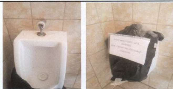
Foto 6.: Sustitución de un mengitorio
