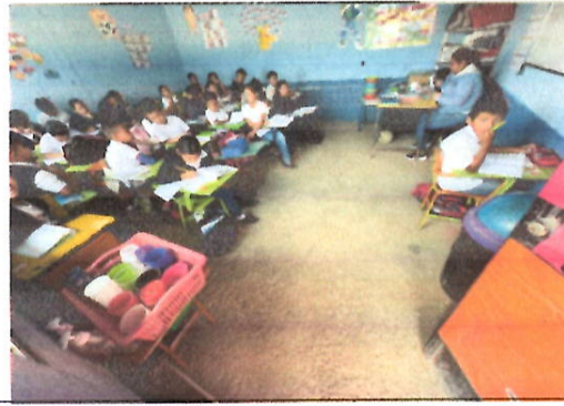
Foto 8: Modulo 1, se debe colocar piso ceramico en aulas
