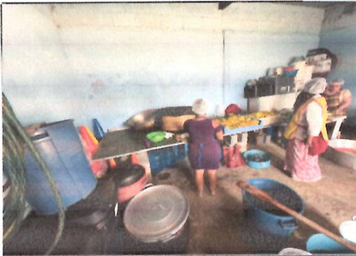
Foto 9: Modulo 1, en cocina se dejara mueble de concreto
