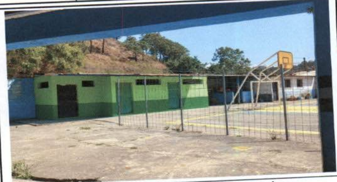
Foto 2: Mejoramiento de sistema eléctrico en aulas y corredor
