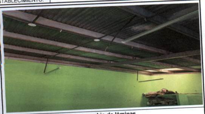
Foto 1: Pintura en estructura y cambio de láminas
