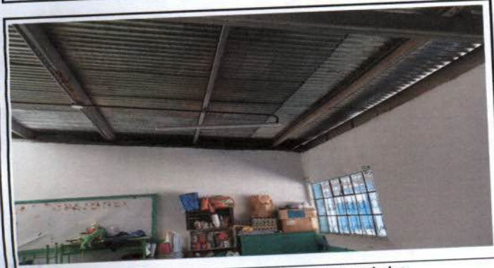
Foto 3: Sustitución de láminas galvanizadas por troqueladas
