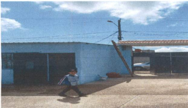
Foto 3: PINTURA DE COSINA Y FACHADA
