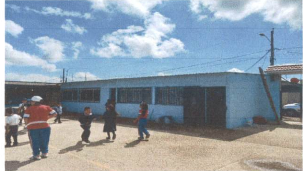
Foto 4: PINTURA DE DE SALON Y COCINA
