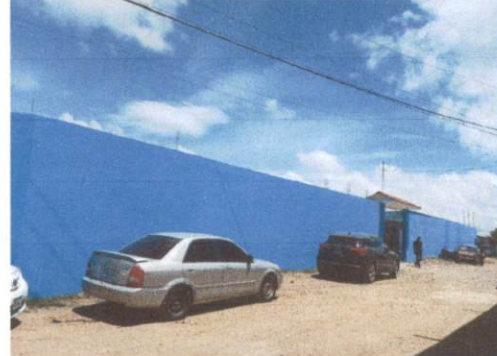
Foto 2: PINTURA DE MURO PERIMETRAL
