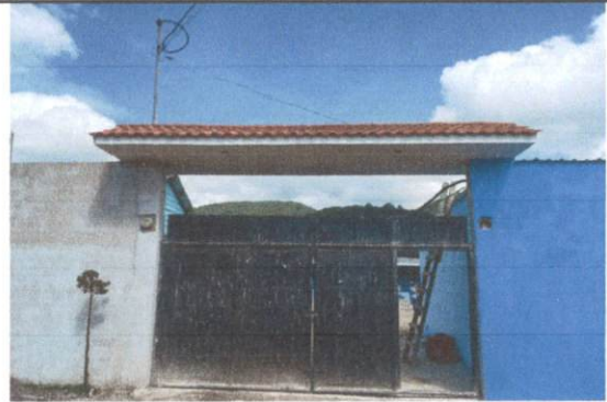
Foto 4: FACHADA DE ESCUELA
