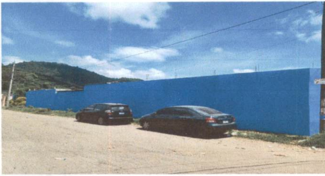
Foto 1: PINTURA DE MURO PERIMETRAL
