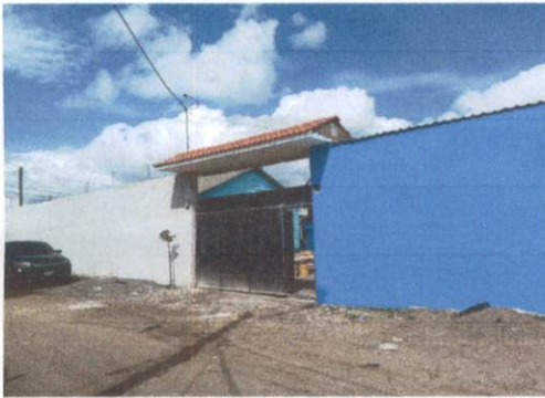
Foto 3: FACHADA DE LA ESCUELA
