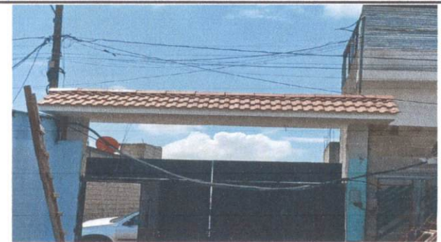
Foto 6: FACHADA DE ESCUELA
