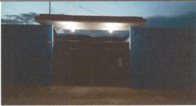
Foto 5: TERMINADA FACHADA DE ESCUELA
