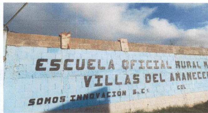
Foto 3: LEVANTAR DOS FILAS DE ALTURA PARA SALON Y COCINA
