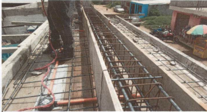
Foto 1: ARMAZÓN DE FACHADA DE PORTÓN
