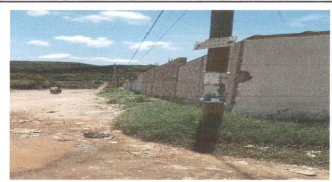
Foto 4: LEVANTADO DE MURO SOBRE MURO
