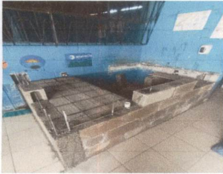
Foto1: PILETA EN CONSTRUCCIÓN
