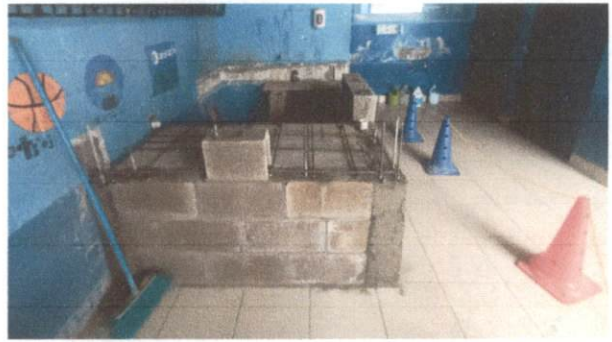
Foto 2: PILETA EN CONSTRUCCIÓN
