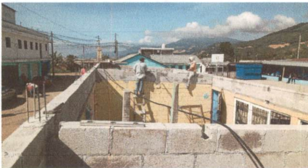
Foto 5: LEVANTADO DE 2 FILAS DE BLOK EN COSINA Y SALON
