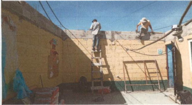
Foto1: LEVANTADO DE 2 FILAS DE BLOK EN COSINA Y SALON
