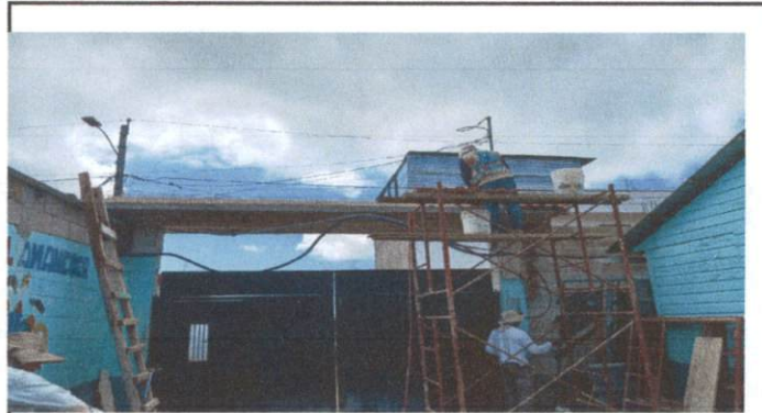
Foto 2: ARMAZÓN DE FACHADA DE PORTÓN
