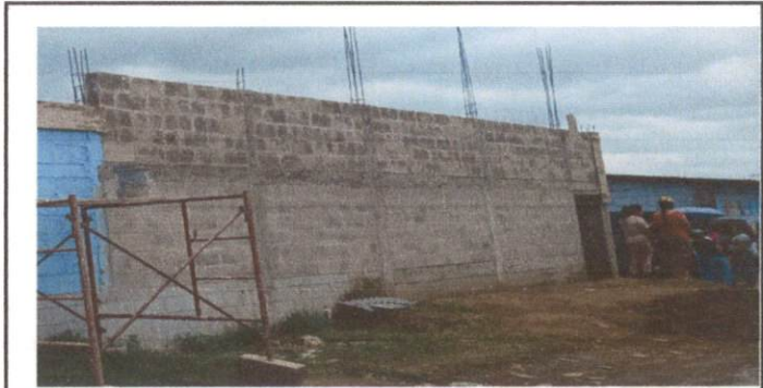
Foto 6: PARED CONSTRUIDA MURO SOBRE MURO
