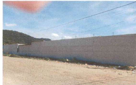
Foto 4: REPELLO DE MURO PERIMETRAL
