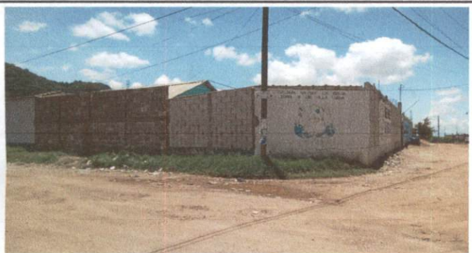
Foto 3: LEVANTADO DE MURO SOBRE MURO
