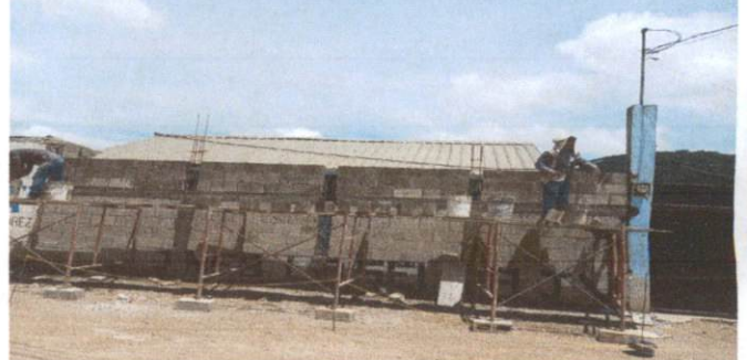
Foto 6: CONSTRUCCIÓN DE MURO SOBRE MURO
