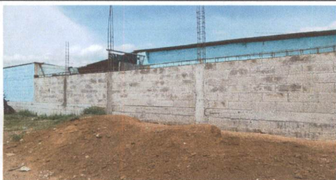
Foto 3: LEVANTAMIENTO DE MURO SOBRE MURO
