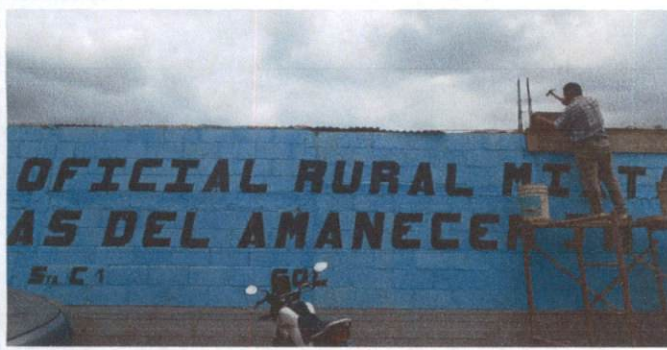
Foto1: LEVANTAR DOS FILAS DE ALTURA PARA SALON Y COCINA
