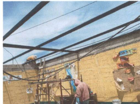
Foto 4: COLOCACION DE COSTANERAS QUE SE DIO MANTENIMIENTO
