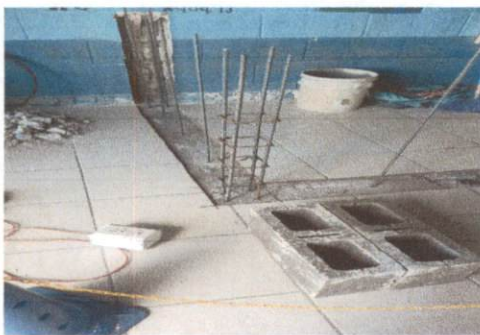
Foto 5: CONSTRUCCIÓN DE PILETA
