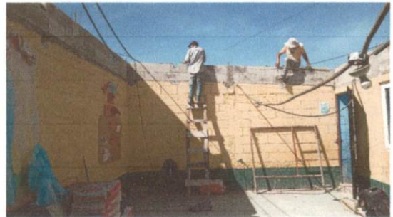
Foto 6: LEVANTADO DE 2 FILAS DE BLOK EN COSINA Y SALON
