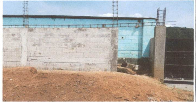
Foto 2: CONSTRUCCIÓN DE BASURERO
