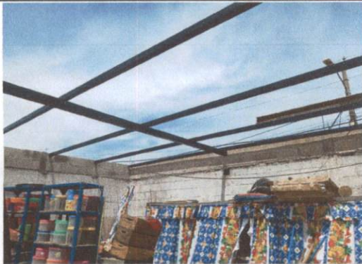
Foto 3: COLOCACION DE COSTANERAS QUE SE DIO MANTENIMIENTO
