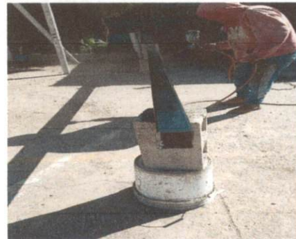
Foto 6: MANTENIMIENTO DE COSTANERAS
