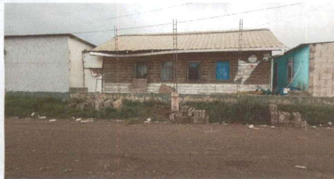
Foto 1: LEVANTADO DE MURO SOBRE MURO *
