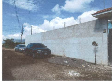
Foto 2: REPELLO DE MURO PERIMETRAL
