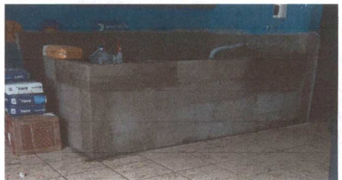
Foto 4: PILETA EN CONSTRUCCIÓN
