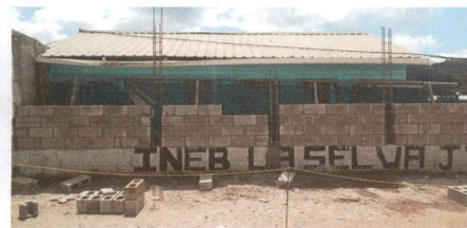
Foto 5: CONSTRUCCIÓN DE MURO SOBRE MURO
