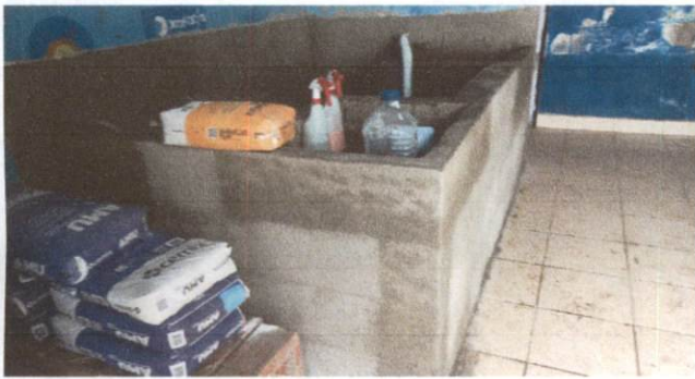
Foto 3: PILETA EN CONSTRUCCIÓN
