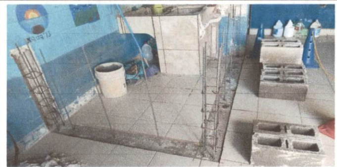
Foto 6: CONSTRUCCIÓN DE PILETA
