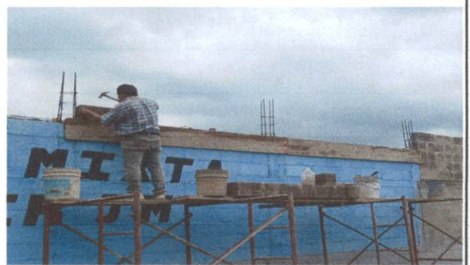
Foto 2: LEVANTAR DOS FILAS DE ALTURA PARA SALON Y COCINA
