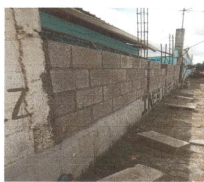
Foto 4: CONSTRUCCIÓN DE MURO SOBRE MURO
