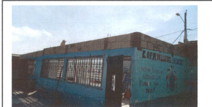
Foto 6: LEVANTADO DE DOS FILAS PARA COCINA
