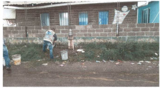
Foto 2: LEVANTADO DE MURO SOBRE MURO
