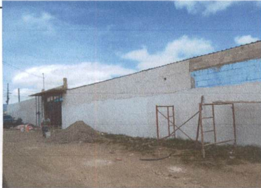
Foto 3: REPELLO DE MURO PERIMETRAL
