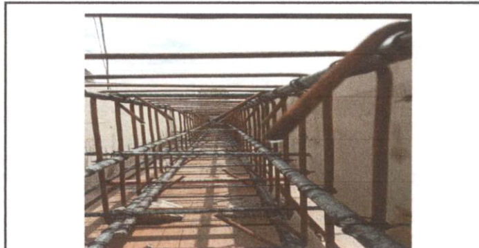
Foto 4: ARMAZÓN DE FACHADA DE PORTÓN
