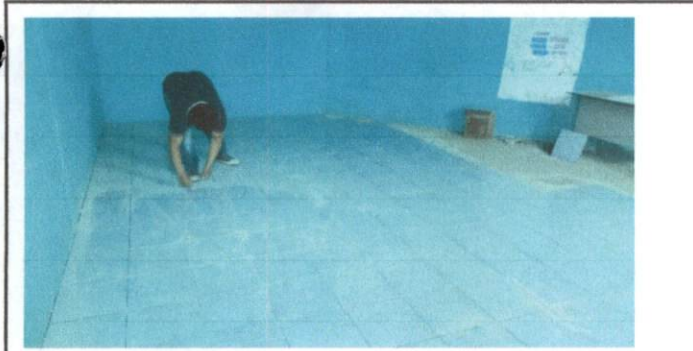
Foto 5: COLOCACIÓN DE PISO
