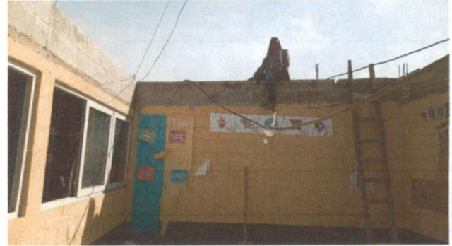
Foto 2: LEVANTADO DE 2 FILAS DE BLOK EN COSINA Y SALON
