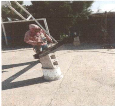
Foto 5: MANTENIMIENTO DE COSTANERAS
