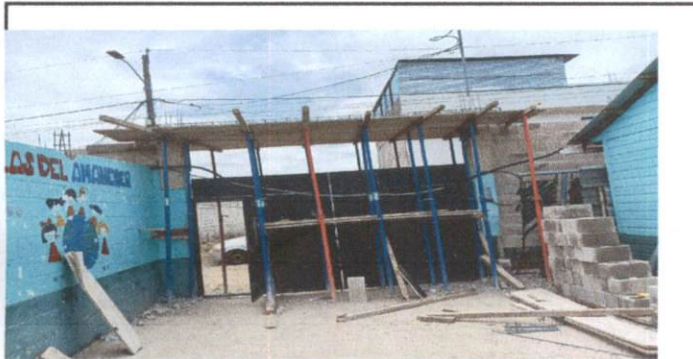
Foto 3: ARMAZÓN DE FACHADA DE PORTÓN
