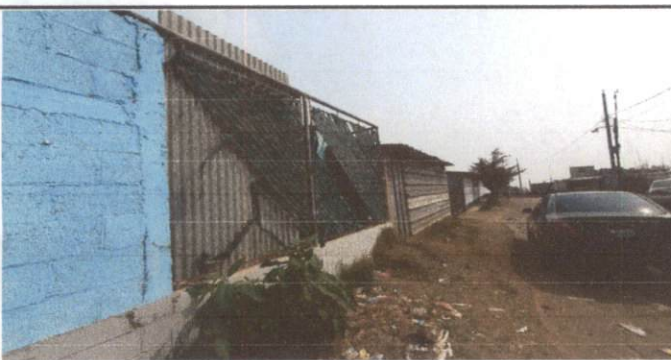
Foto 3: CONSTRUCCIÓN DE MURO SOBRE MURO
