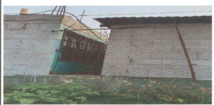
Foto 2: CONSTRUCCIÓN DE MURO SOBRE MURO
