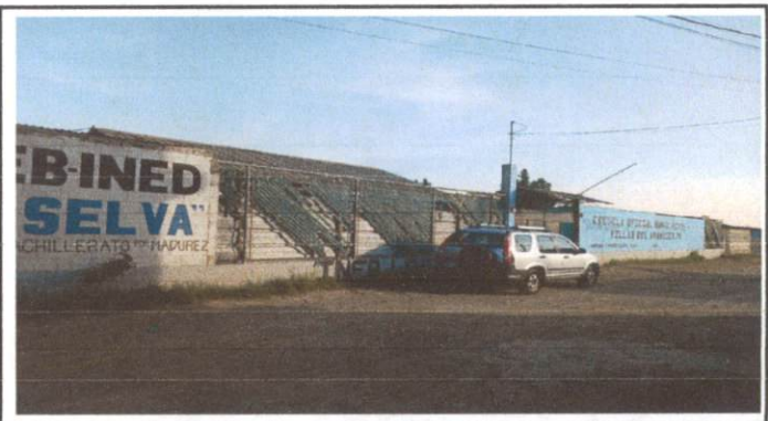
Foto 4: CONSTRUCCIÓN DE MURO SOBRE MURO
