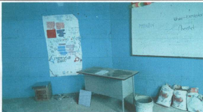
Foto 3: PREPARACIÓN DE MATERIAL PARA COLOCACION DE PISO
