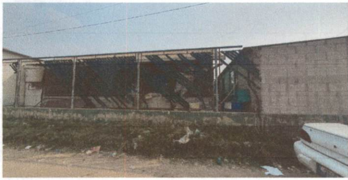
Foto 1: CONSTRUCCIÓN DE MURO SOBRE MURO
