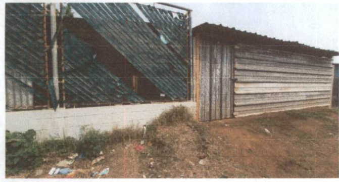
Foto 1: RECONSTRUCCIÓN DE BASURERO / CONSTRUCCIÓN DE MURO SOBRE MURO
