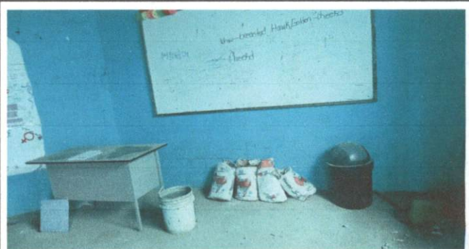
Foto 2 COLOCACIÓN DE PISO
