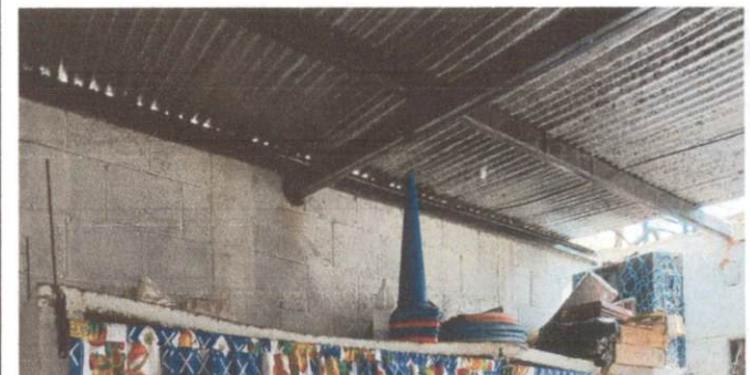
Foto 6: CAMBIO DE LÁMINA
