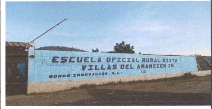
Foto 2: LEVANTADO DE DOS FILAS DE BLOCK
