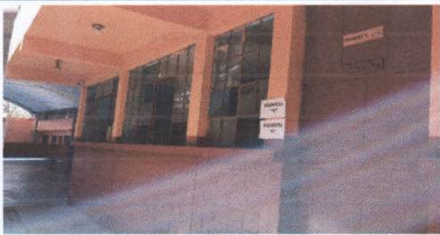
Foto 3: Sustitución de cristales y ventanas
