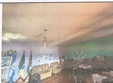
Foto 11: Modulo 2, es necesario impermeabilizar losa para evitar humedad
