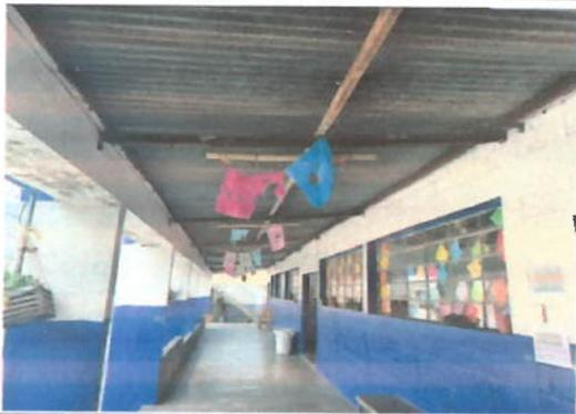
Foto 9: Modulo 2, es necesario sustitucion de lamina
