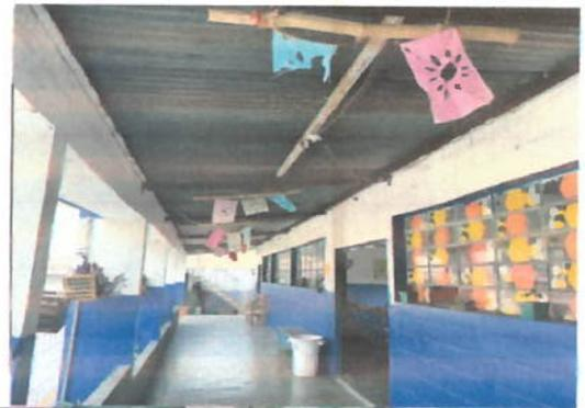
Foto 10: Modulo 2, es necesario sustitucion de lamina
