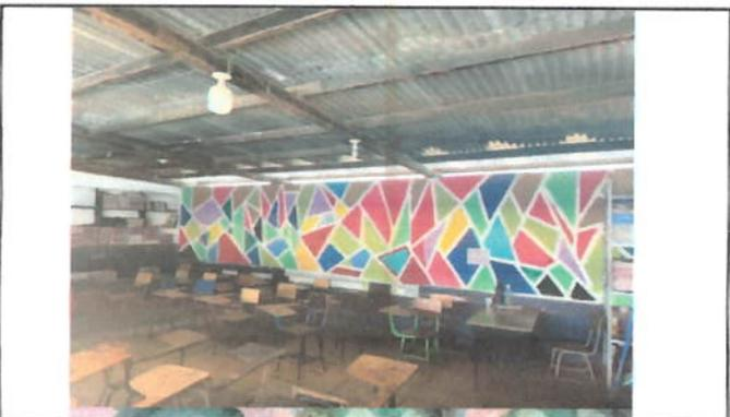
Foto 4: Modulo 1, es necesario darle mantenimiento a estructura de soporte y sustitucion de lamina
