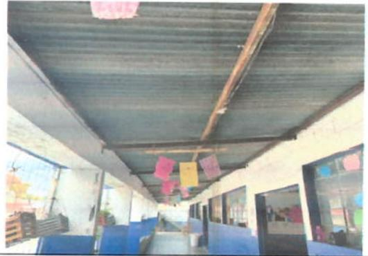
Foto 8: Modulo 2, es necesario sustitucion de lamina
