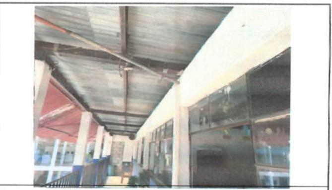
Foto 6: Modulo 1, es necesario darle mantenimiento a estructura de soporte y sustitucion de lamina
