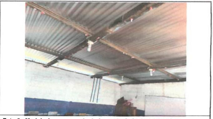
Foto 5: Modulo 1, es necesario darle mantenimiento a estructura de soporte y sustitucion de lamina
