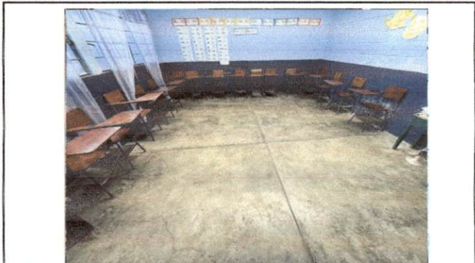
Foto 3: Modulo 1, se colocara piso ceramico ✓
