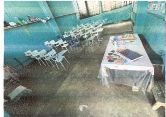
Foto 10: Se colocara piso ceramico en aulas
