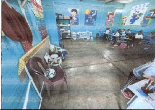
Foto 7: Se colocara piso ceramico en aulas
