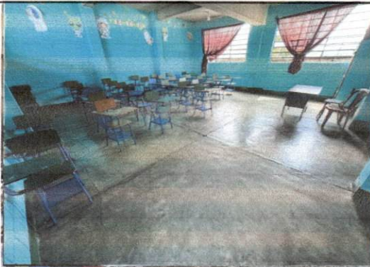
Foto 11: Se colocara piso ceramico en aulas
