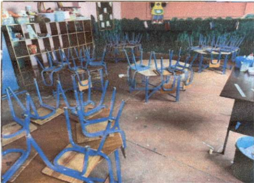
Foto 9: Se colocara piso ceramico en aulas
