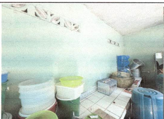
Foto 5: Se dejara plancha de concreto en cocina
