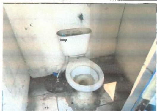
Foto 4: Sanitarios en mal estadoes necesario sustituirlos, es necesario colocar piso ceramico y azulejo
