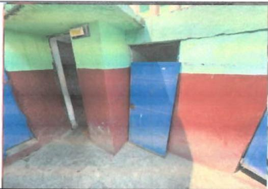
Foto 5: Puertas en mal estado es necesario sustituir las
