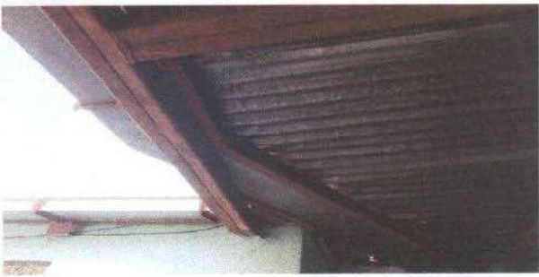
Foto 1.: Mantenimiento de estructuras
