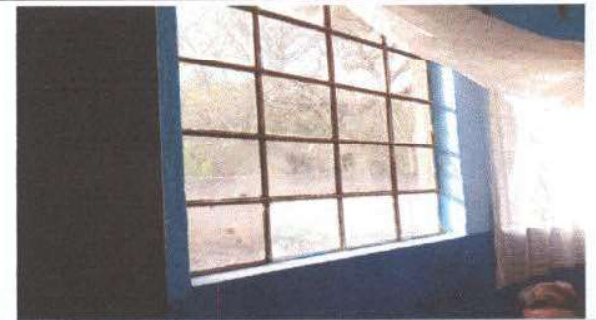
Foto 6.: Mejoramiento de ventanas
