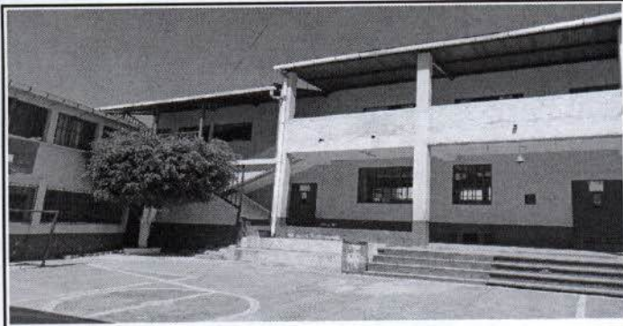
Foto 1: Bajadas pluviales desde el 2do nivel
