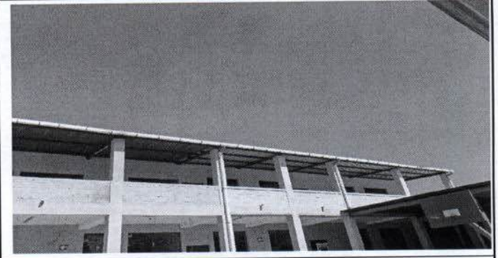
Foto 2: Cambio de láminas en 2do nivel
