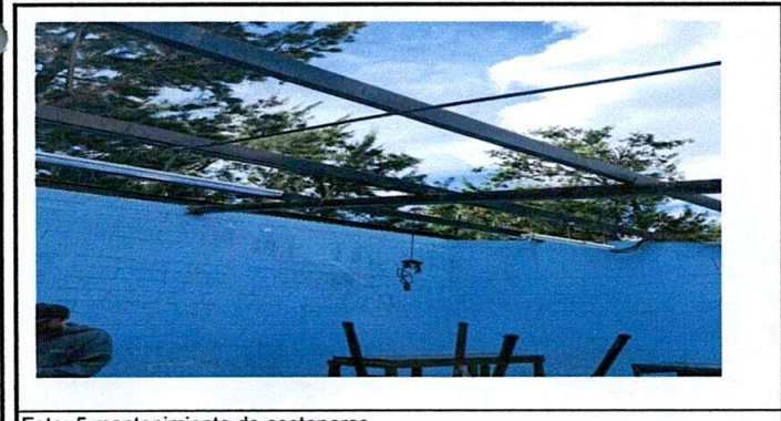
Foto: 5 mantenimiento de costaneras
