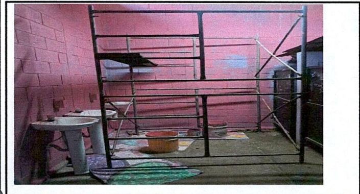
Foto: 1 pintura en baños
