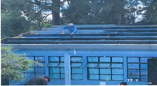
Foto: 1 Pintura y mantenimiento en costaneras
