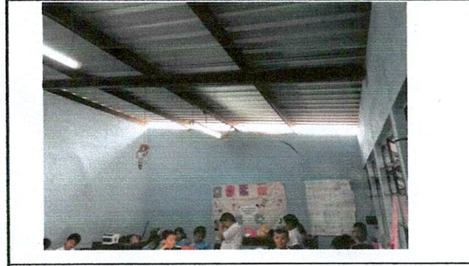
Foto: 4 cambio de lamina
