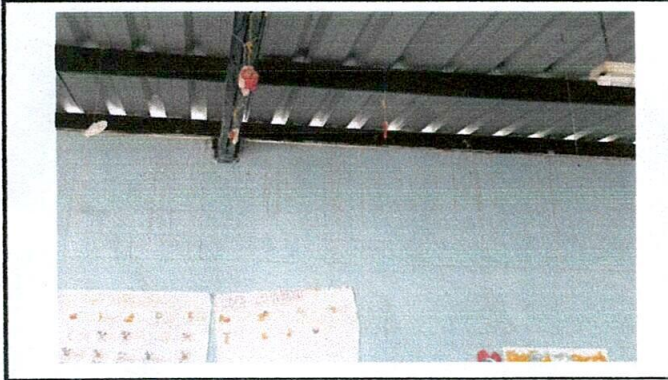
Foto: 3 pintura en costaneras
