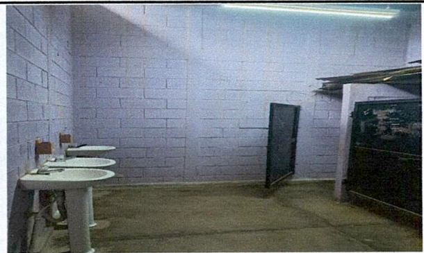
Foto: 4 pintura en baños
