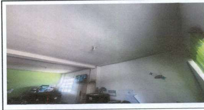
Foto 4: Piso en aulas
