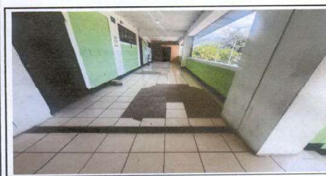
Foto 5: Piso el corredor del segundo nivel modulo 1
