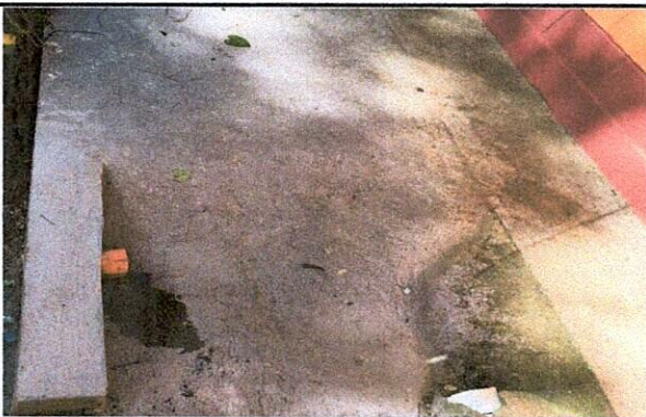
Foto 3: Fundición y colocación de desagüe de módulo 2.
