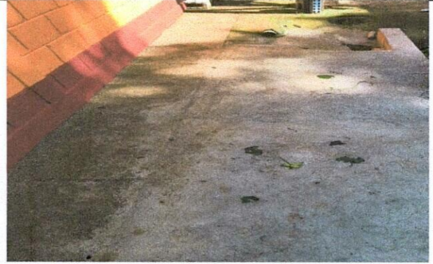
Foto 2: Fundición de banqueta módulo 2
