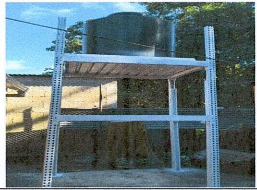
Foto 2: Estructura y rotoplas remozado.
