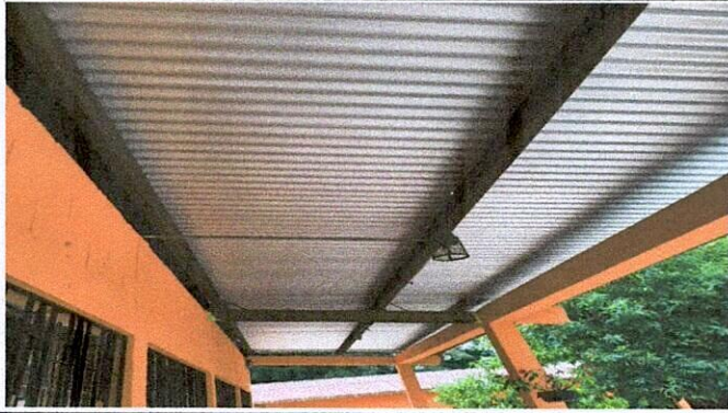
Foto1: Colocación de lámina en módulo 1 concluida.
