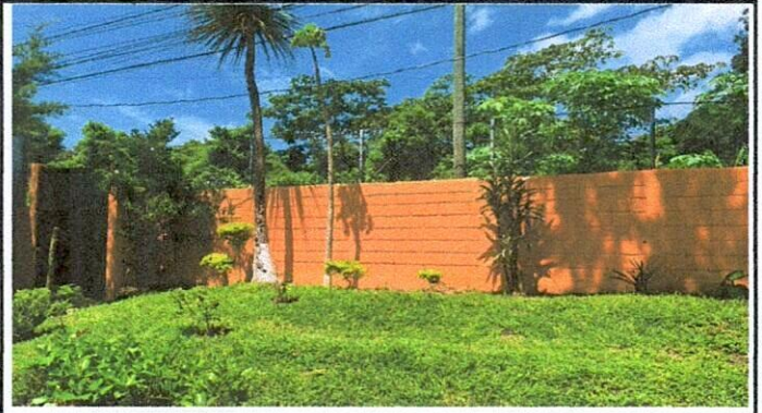
Foto 2: Muro perimetral pintado y cambio de malla de enfrente.
