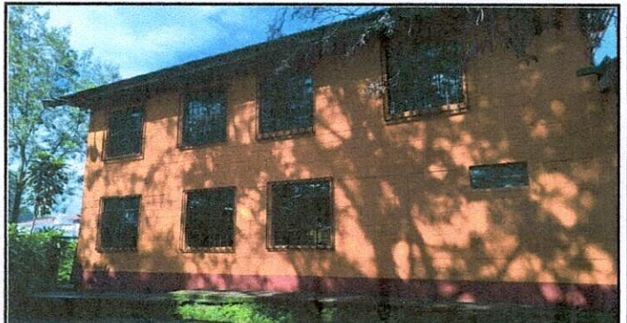
Foto 6: Pintura de atrás concluida módulo 3.
