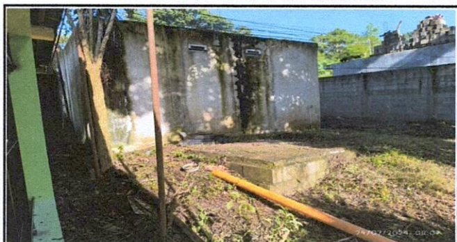
Foto 6: Remoción malla perimetral, módulo 1.
