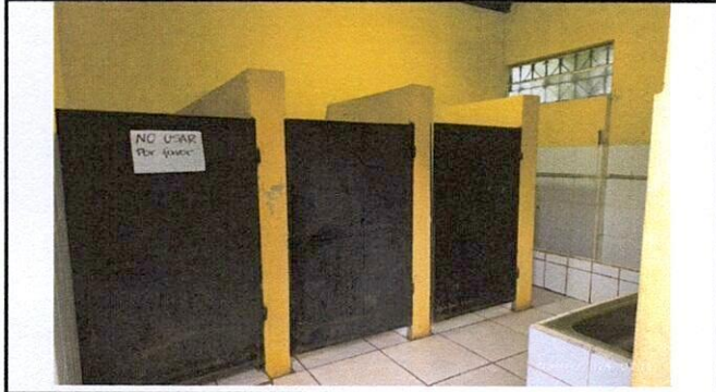
Foto1: Baño de niños previo a su remozamiento
