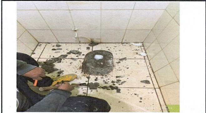
Foto 2: Cambio de sanitarios, baño de niños.
