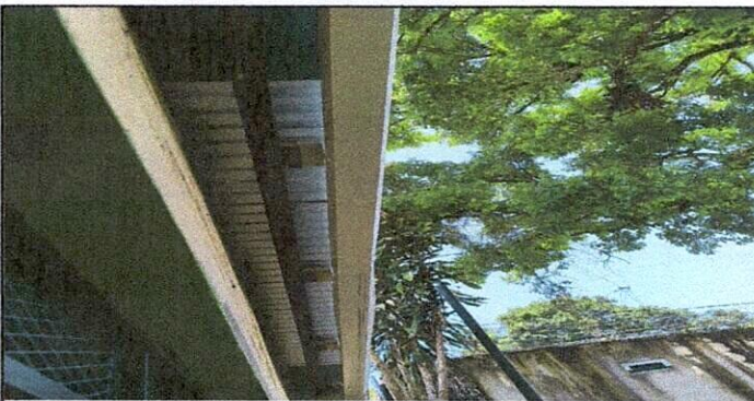
Foto 5: Colación de canal parte de atrás de módulo 1.
