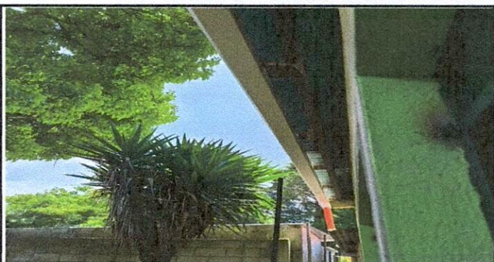
Foto 6: Colocación de canal de parte de atrás de módulo 1.
