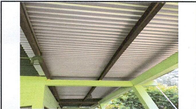
Foto 3: Cambio de lámina módulo 1.
