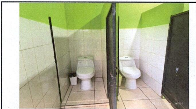
Foto 3: Colocación de sanitarios en baño de niños.
