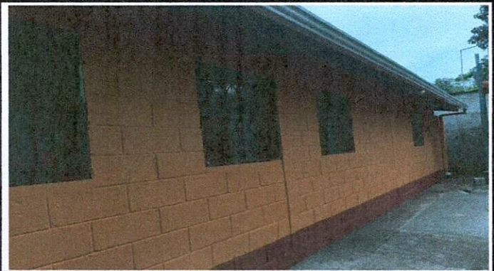
Foto 2: Parte de atrás módulo 2, pintado y con canal.
