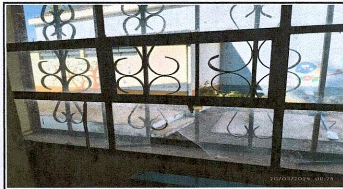
Foto 3: Cambio de viarios rotos, 9 en total.
