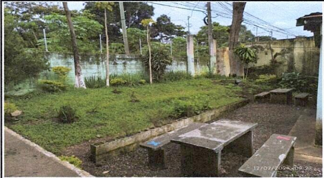
Foto 2: Instalaciones previo a pintar.
