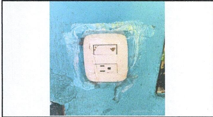
Foto 1: Cambio de interruptores de luz, 4 en total.
