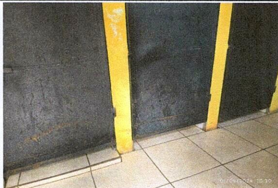
Foto 3: Mantenimiento a puertas de baños de niños y niñas, 6 en total
