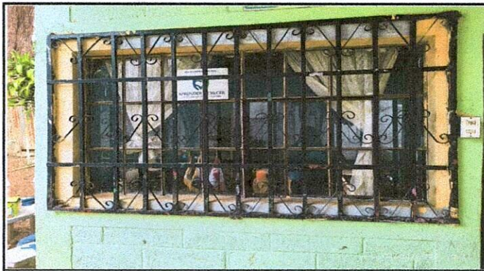
Foto 2: Balcón a sustituir
