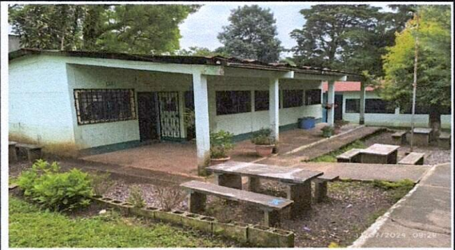
Foto 1: Instalaciones previo a pintar
