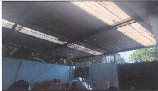
Foto 7: Mantenimiento a estructura de techo
