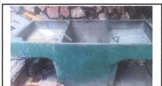
Foto 5: Instalación de eborro
