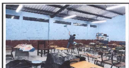
Foto 6: Pintado de paredes en aulas del primer y segundo nivel.
