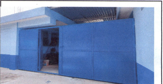
Foto 6: SUMINISTRO E INTALACION DE PORTON + RESANE DE PUERTAS EXISTENTE EN LA ENTRADA DE LA ESCUELA
