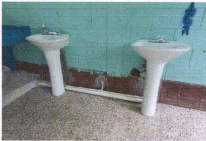
FOTO 7: INSTALACIÓN DE LAVAMANOS CON SUS ACCESORIOS
