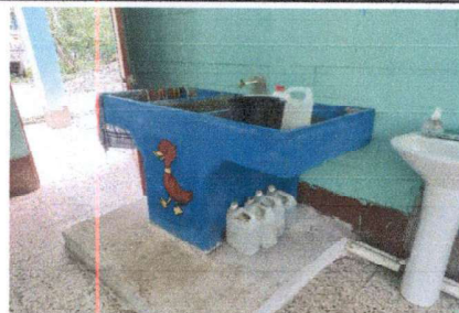
FOTO 10: INSTALACIÓN DE PILA DE CONCRETO DE DOS LAVADEROS
