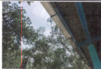
FOTO 4: INSTALACIÓN DE CANAL PARA AGUA PLUVIAL EN LÁMINA
