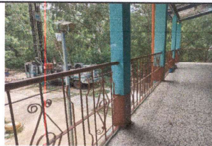
FOTO 6: MANTENIMIENTO DE BARANDA DE METAL EN SEGUNDO NIVEL
