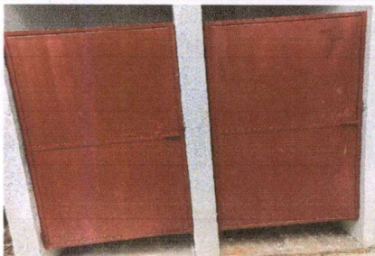
FOTO 9: SUSTITUCIÓN DE PUERTAS DE METAL EN SANITARIOS
