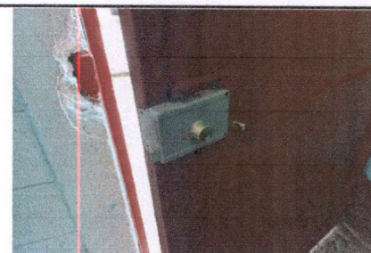
FOTO 12: SUSTITUCIÓN DE CHAPAS EN PUERTAS
