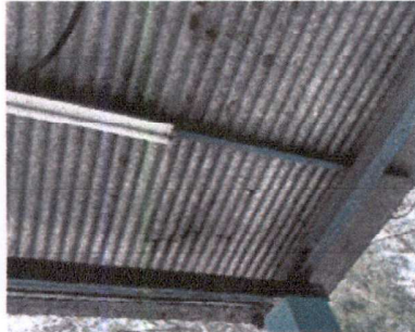
Foto 1 : Área del corredor segundo nivel, cambio de láminas (15)
