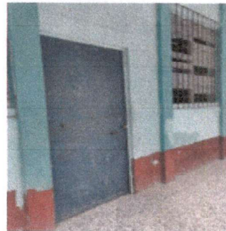
Foto 4: Mantenimiento a 5 puertas 3 puertas segundo nivel y 2 en el primer nivel.
