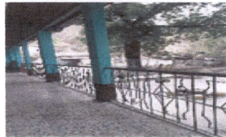
Foto 10 Mantenimiento de barandas
