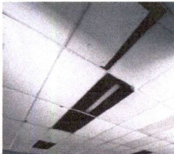
Foto 3 Estructura de cielo falso e instalación 22.5 metros, aula de tercero básico y bodega.
