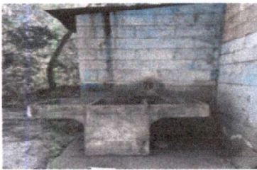
Foto 11: Reparación área baños , plancha de concreto
