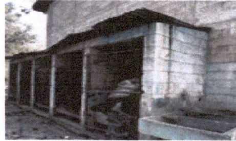
Foto: 2 Área del baño, cambio de láminas 10
