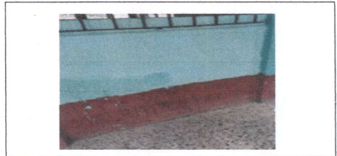
Foto 16: Pintura en paredes del segundo nivel (externo)
