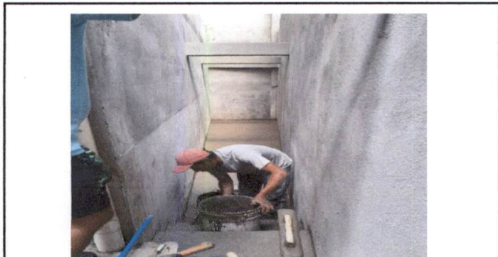
FOTO 5: REPELLO EN BODEGA Y FUNDICION DE TORTA DE CEMENTO
