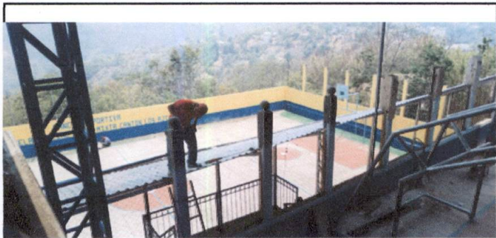
FOTO 3: TALLADO EN COLUMNAS PARA SUGETAR LAS BARANDAS
