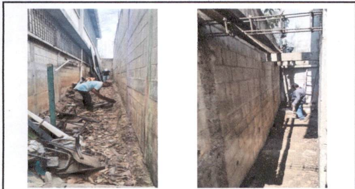
FOTO 1: LIMPIEZA EN PASILLO Y BODEGA
