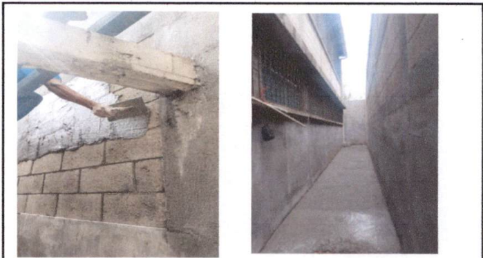
FOTO 2: REPELLO EN PAREDES Y FUNDICION DE TORTA DE CEMENTO EN PASILLO
