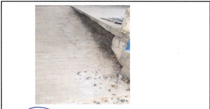
FOTO 6: REPARACION DE GRIETAS EN MURO
