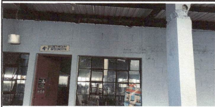
Foto 5 Salón que se encuentra en 2do. Módulo donde se remozará para cocina
