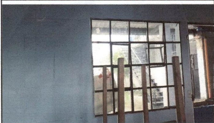
Foto: 7 Primera ventana que se estará agregando balcon por seguridad.
