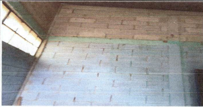
FOTO 7. SE PINTARA Y CAMBIARAN VENTANAS EN LOS SANITARIOS DE NIÑOS Y NIÑAS
