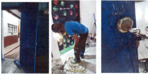
Foto 5: mantenimiento a estructura
