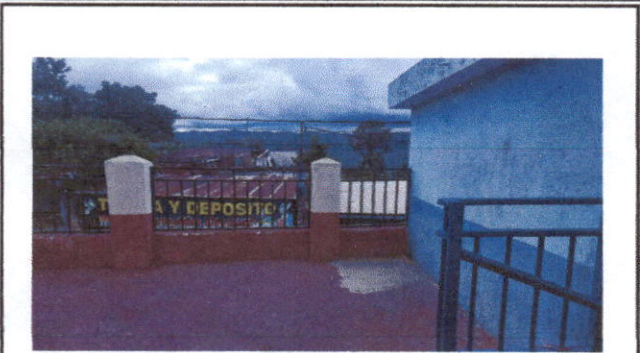
Foto 7: ÁREA PARA TECHAR CON LÁMINA Y ESTRUCTURA METÁLICA
