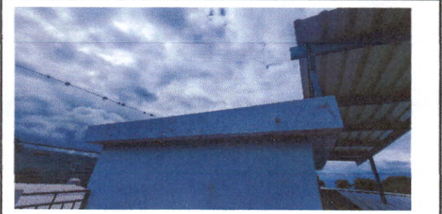
Foto 9: IMPERMEABILIZACIÓN DE PAÑUELOS Y LOSA DEL MÓDULO QUE SE CONVERTIRÁ EN LA BODEGA DE LA ESCUELA
