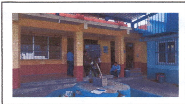
Foto 5: POZO DE AGUA POTABLE PARA LA DISTRIBUCIÓN DE LA BATERIA DE SERVICIOS SANITARIOS
