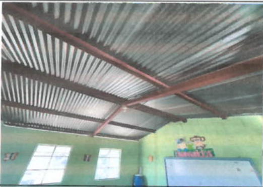
Foto 11: Modulo 4, lamina en mal estado, es necesario sustituirla
