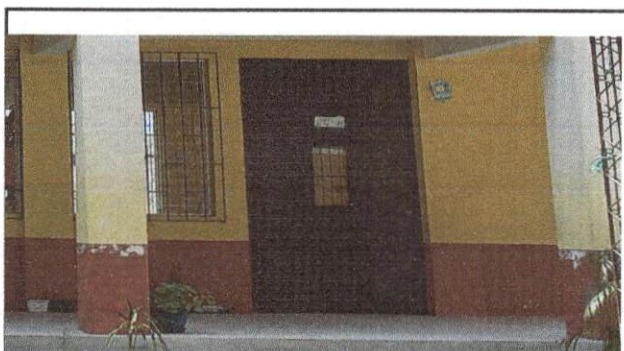
Foto 4: REPARACION DE PUERTA
