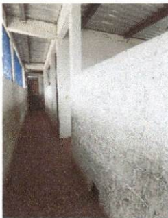
Foto 5: MÓDULO No. 2 AULAS 2DO. NIVEL SE NECESITA EL REPELLO Y CERNIDO DEL PASILLO
