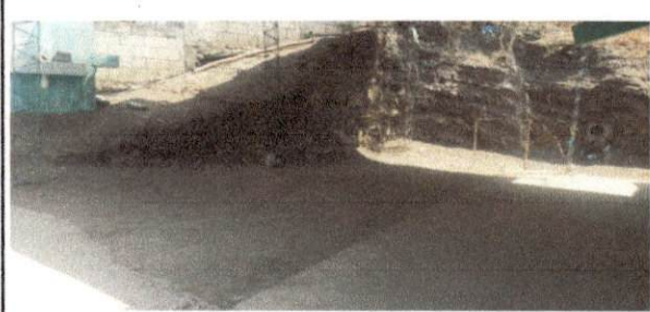
Foto 6: MÓDULO NO. 3 INGRESO Y PATIO, EN EL PATIO SE ENCUENTRA UN ÁREA DE CORTE DE MURO DE TIERRA, EN EPOCA LLUVIOSA TIENDE A DESLAVES EN EL ÁREA DEL PATIO POR LO QUE SE NECESITA UN TERRAPLEN
