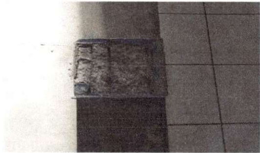
foto 15: demolição de base de concreto
