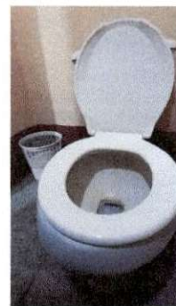
Foto 6: Arreglo de sanitarios en sala de profesores
