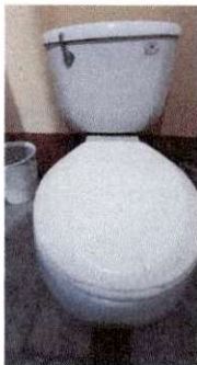
Foto 5: Arreglo de sanitarios en sala de profesores
