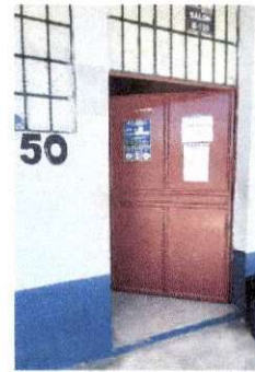
Foto 10: Arreglo de puertas en salones de clases
