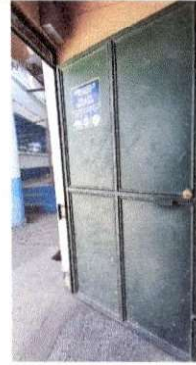
Foto 8: Arreglo de puerta en sala de profesores
