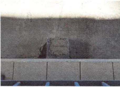
foto 13: demolição de base de concreto
