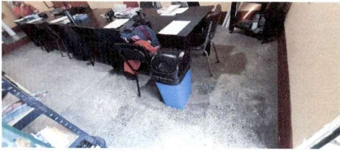
Foto 3: Colocación de piso cerámico en sala de profesores
