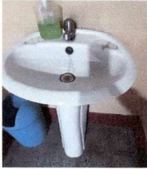
Foto7: Arreglo de lavamanos en sala de profesores
