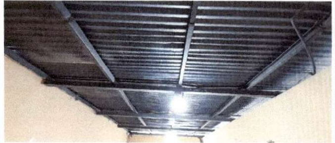
Foto 4: Colocación de cielo falso en Sala de profesores
