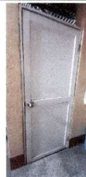
Foto 9: Arreglo de puertas en sanitarios
