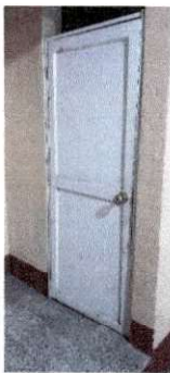
Foto 9: Arreglo de puertas en sanitarios
