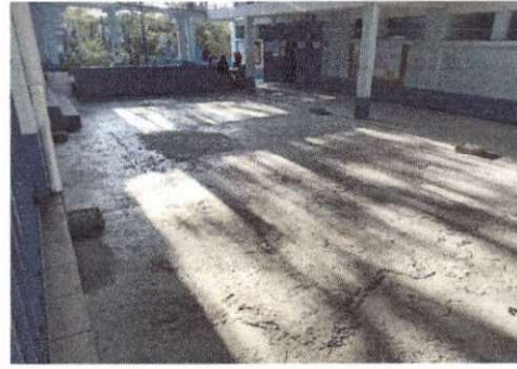
Foto 14: Instalación de piso cerámico en patio
