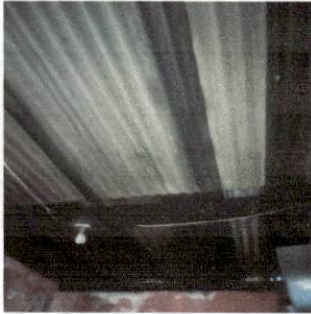
Foto7: Sustitución de techo de madera por costaneras
