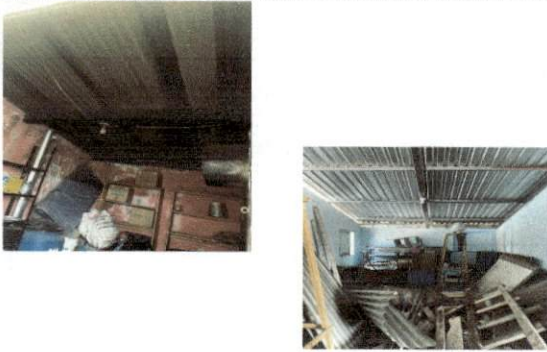
Foto 8: levantamiento de solera
