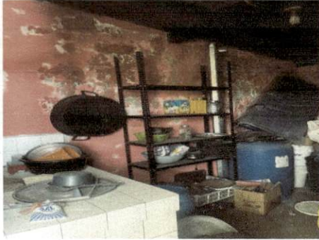
Foto1: Repello de paredes
