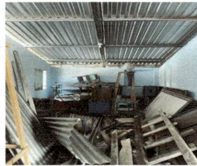
Foto 4: retirar una parte del muro para ampliacion y union con lo que seria la bodega. Colocar 1 puerta
