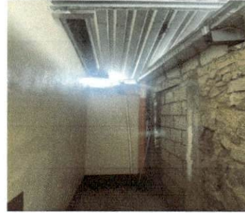
Foto 8: levantamiento de muro interno
