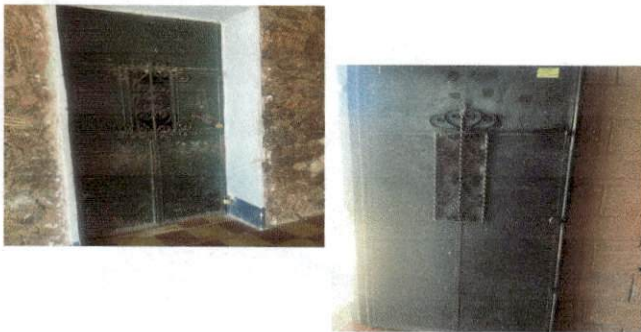
Foto 10: mantenimiento y repacion de puerta de cocina y de la direccion
