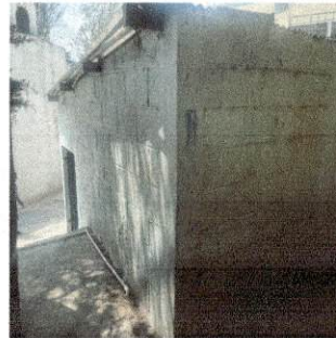
Foto 16: mejoramiento de paredes
