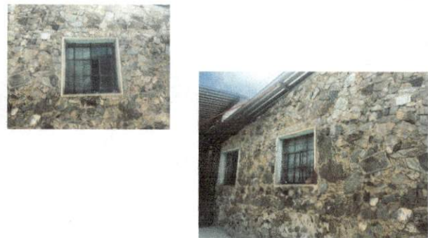
Foto 11: colocar ventanas nuevas
