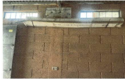
Foto 14: mejoramiento de paredes y aplicación de socalo para evitar humedad
