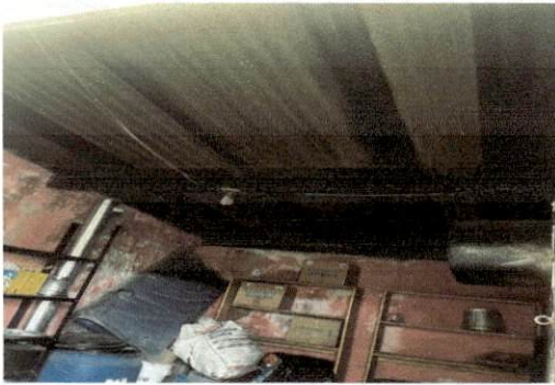
Foto 3: cambio de techo, base de madera por costaneras y lamina troquelada.
