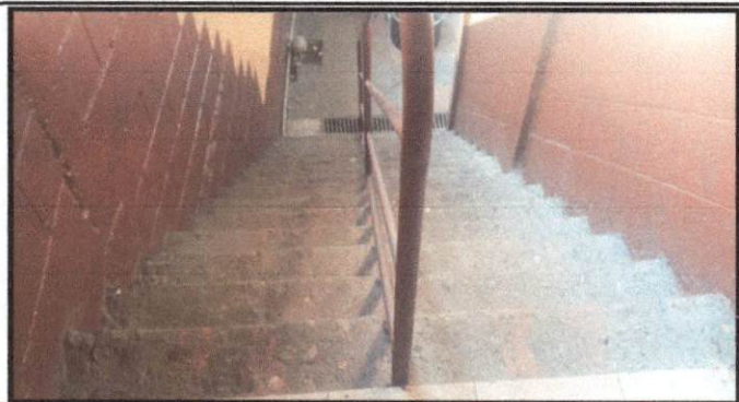
Foto 5: Sustitucion de piso de torta de concreto
