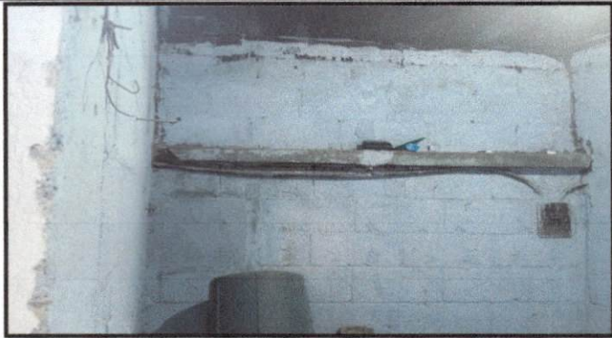
Foto 1: Sernido de paredes de bodega de cocina
