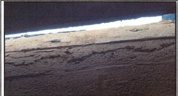
Foto 4: aplicación de sabieta en muro de contención
