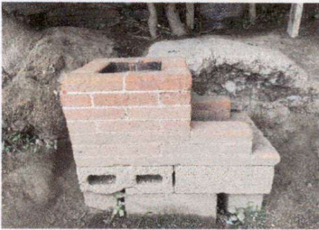
Foto 9: Sustitución de estufa rural completa.
