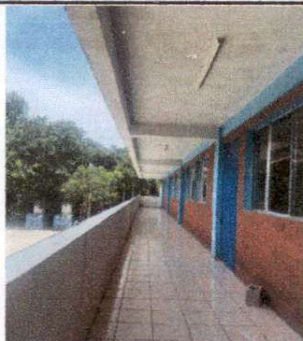
Foto 3: Remozamiento e impermeabilización de losa del segundo nivel debido a filtraciones de agua.
