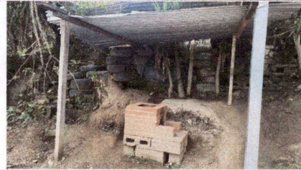
Foto 10: Sustitución de estructura y cubierta de lámina troquelada.
