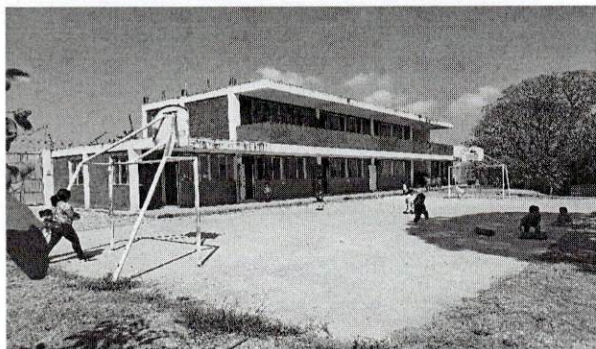
Foto 3: Módulo No. 1: Debido a la lluvia, la escuela necesita la pintura de exterior e interior
