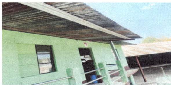
Foto 4: Cambio de estructura de Techo y cubierta de lamina troquelada
