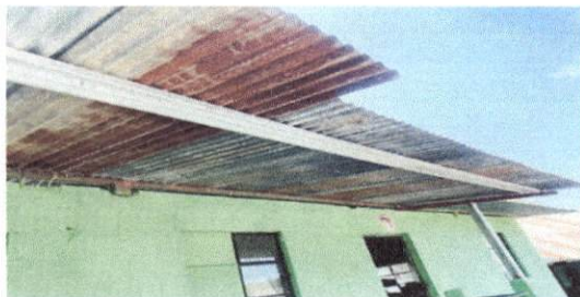
Foto 3: Cambio de estructura de Techo y cubierta de lamina troquelada
