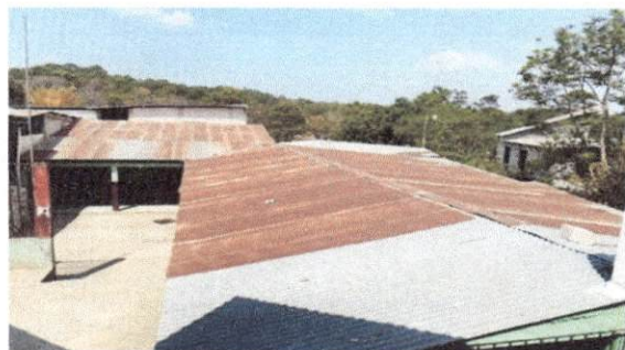
Foto 5: Cambio de estructura de Techo y cubierta de lamina troquelada
