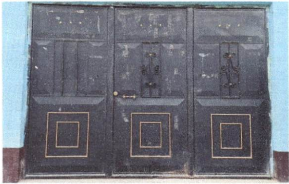
Foto 7: Cambio de porton principal
