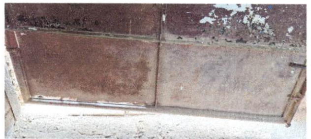
Foto 12: Cambio de porton de salida de emergencia hacia el campo
