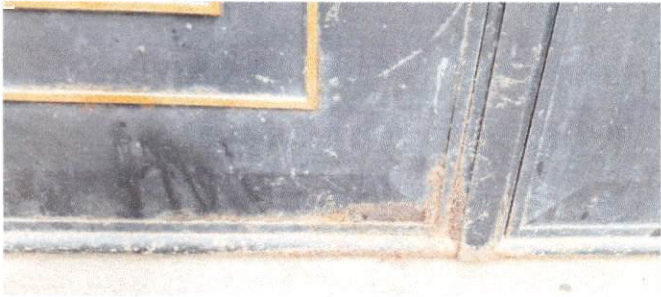
Foto 9: Cambio de porton principal
