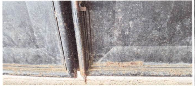
Foto 8: Cambio de porton principal
