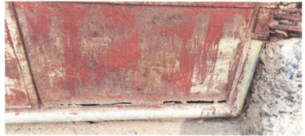
Foto 10: Cambio de porton de salida de emergencia hacia el campo
